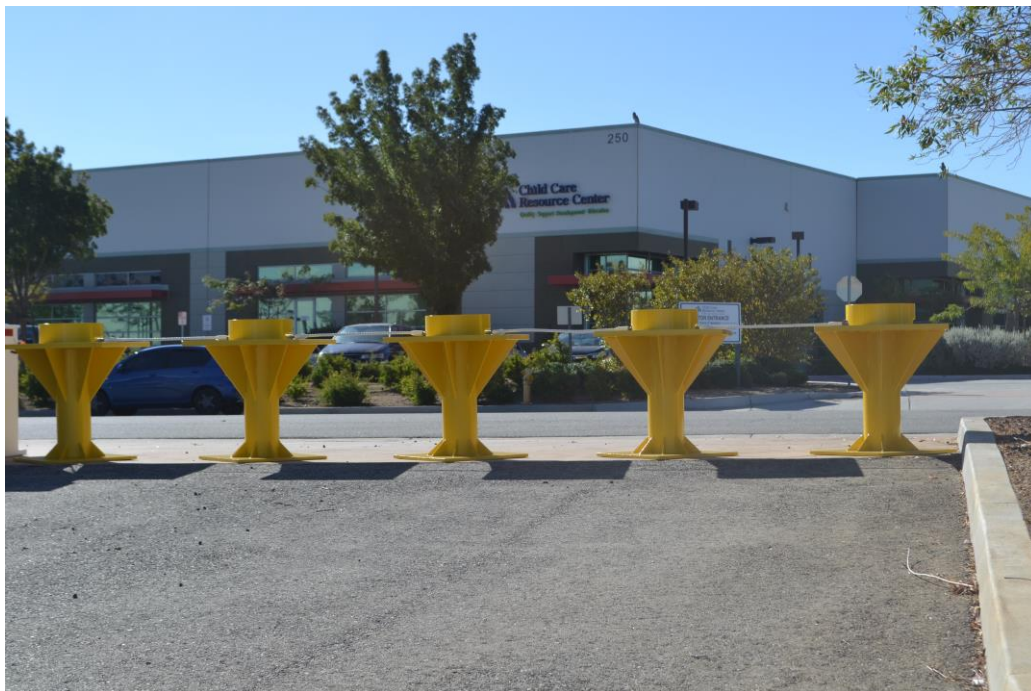
TB 100 Bollard Array
